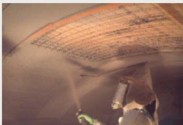
▲②吹付け作業
