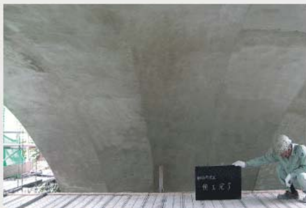
▲④コテ仕上げ完了
