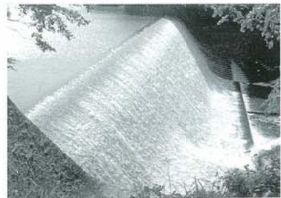
▲写真-3 白水ダム
