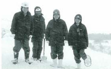
▲写真-1 山王海ダム 土取場調査
