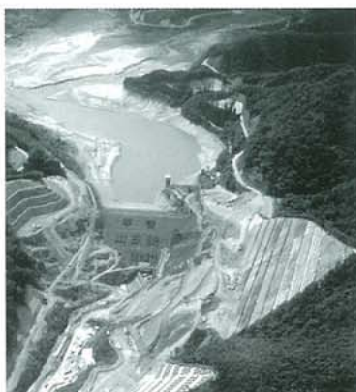
▲写真-2 山王海ダム(工事中)
