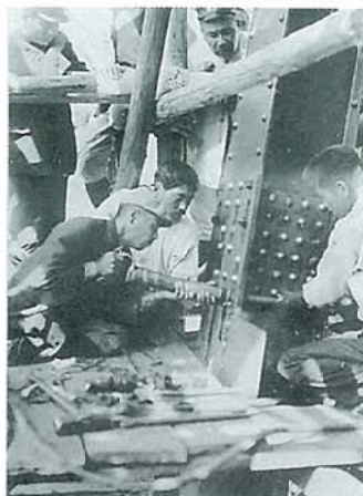
▲リベット打ち(提供: 土木学会図書館)
