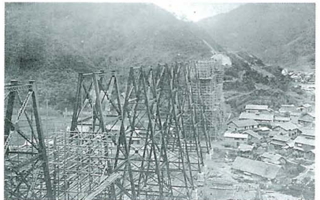
▲工事中(提供: 土木学会図書館)
