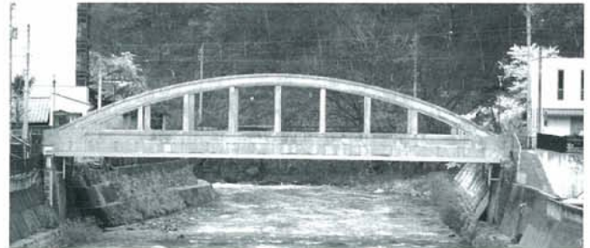
▲写真-1 世界初のRCローゼ桁 大手橋
