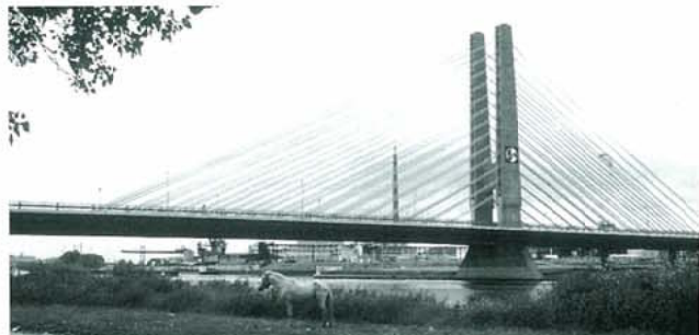
▲写真-2 第二メイン橋(1982年)
