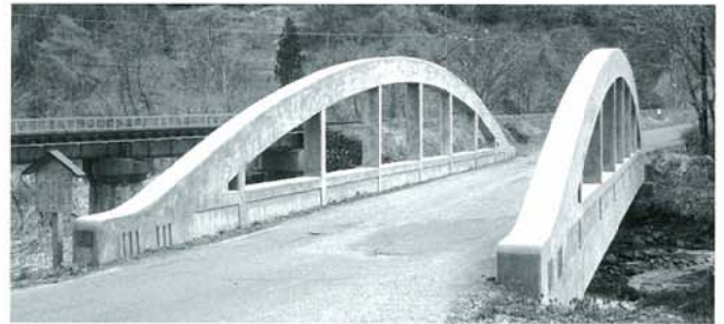
▲写真-2 最近修復された親沢橋
