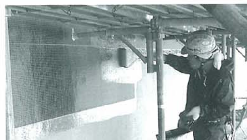
▲写真-2 炭素繊維シート施工状況
