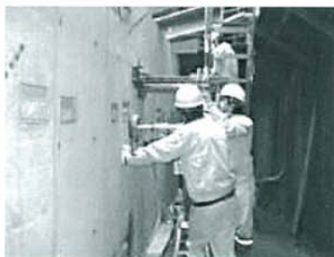
▲写真-4 フーチング側面コア採取
