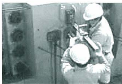
▲写真-2 橋梁上部工建設現場 小径コア採取状況
