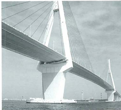
▲写真-1 鶴見つばさ橋全景
