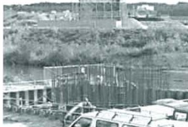
▲写真-3 河川内中間部橋脚
