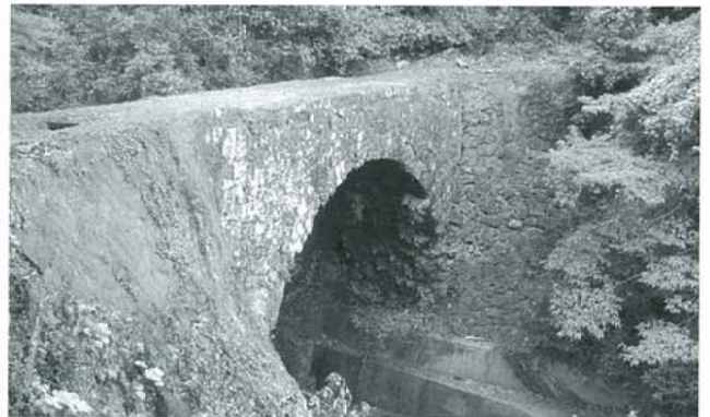
▲写真-2 雄亀滝橋(おけだけ橋)
