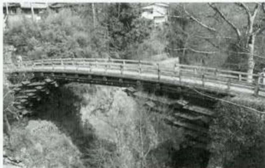
▲写真-1 猿橋全景
