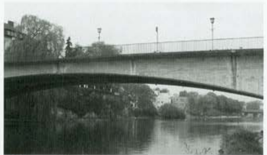
▲写真-3 ヘルド橋
