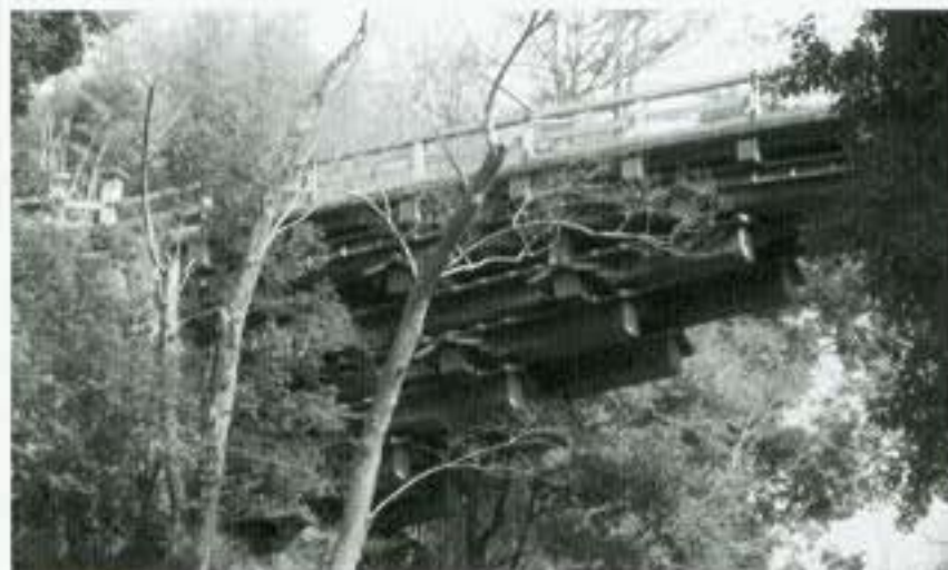
▲写真-2 岩盤から張出された刎ね木
