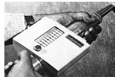
▲写真-3 当時のシュミットコンクリートハンマー
