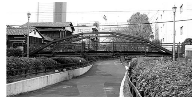
▲写真-2 旧弾正橋
