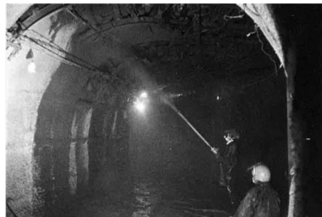
▲写真-2 青函トンネルでの吹付の様子
