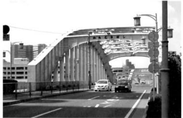
▲写真-1 晴海側よりの勝どき橋
