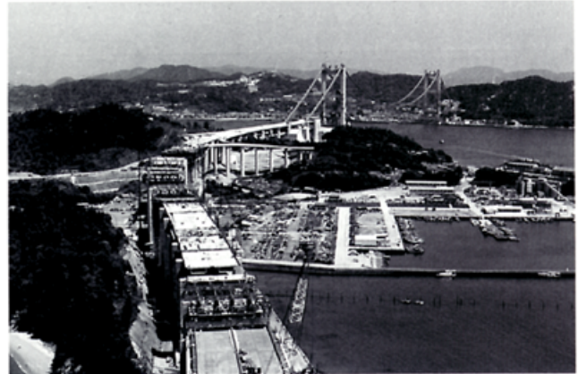
▲写真-2 櫃石島工事全景
