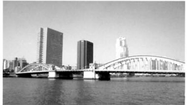
▲写真2 下流側より
