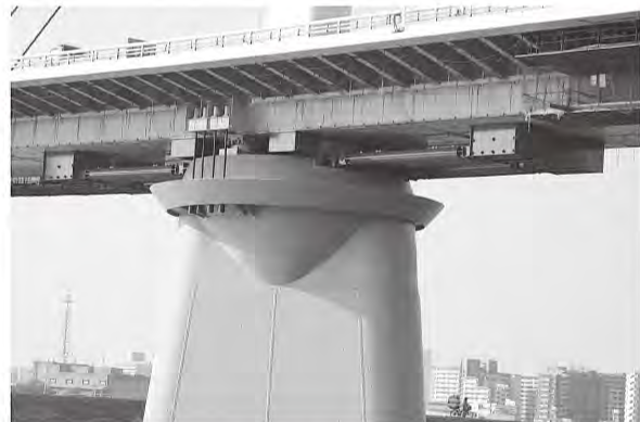
斜張橋の耐震補強工事(首都高:かつしかハープ橋)
