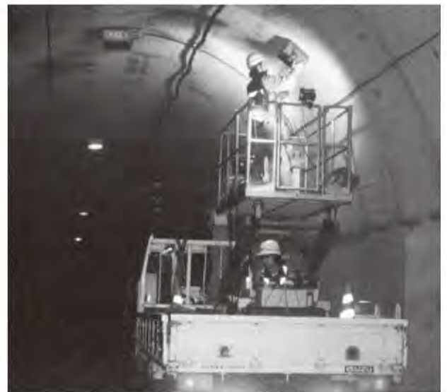
レーダ探査による覆工背面空洞探査状況
