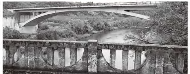
写真-3 5代目眼鏡橋高欄の逆アーチ
