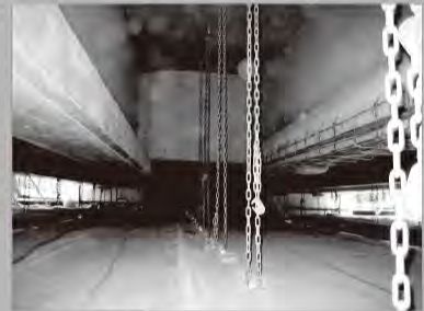
▲ 断面修復工事
