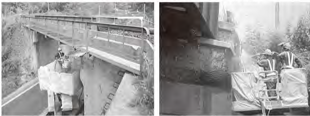
▽写真 乾式吹付け施工状況 (下国道、上鉄道)
