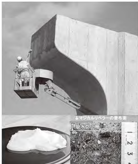
コンクリートの耐久性を向上する表面含浸工法 浸透性吸水防止材「マジカルリペラー®」
