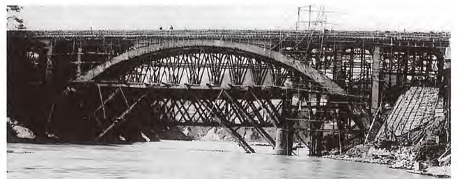
写真-5 5代目の施工状況
