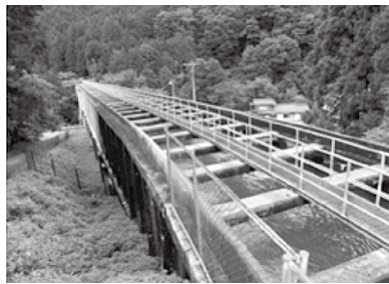
写真-2 柿其水路橋 上部工
