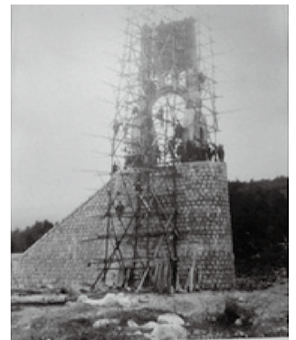
写真-6 桃介橋 建設中
