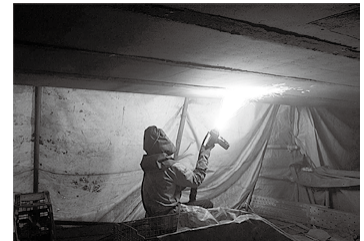
チタン溶射状況
