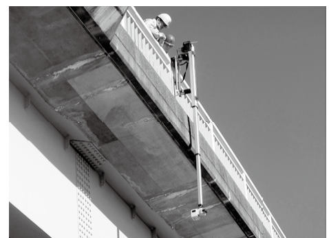
橋梁点検ロボットカメラ
