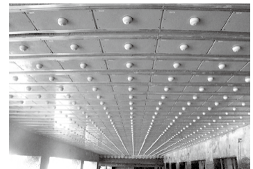
栈橋へのALAPANEL方式適用例
