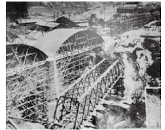
写真-5 柿其水路橋 建設中
