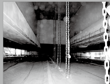
△ 断面修復工事
