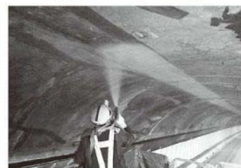
写真-3 施工状況
