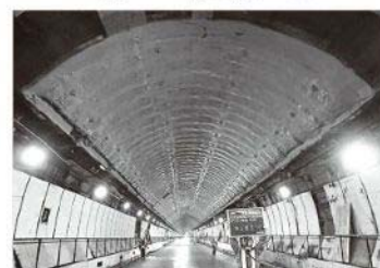
写真-2 トンネル施工例
