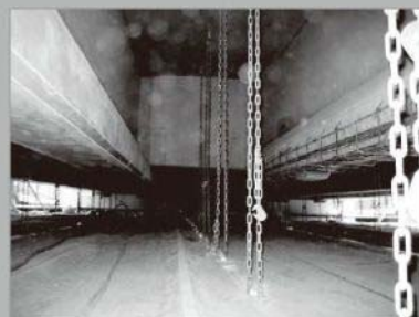
▲ 断面修復工事
