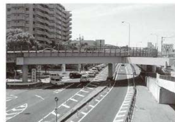
写真-1 跨道橋施工例
