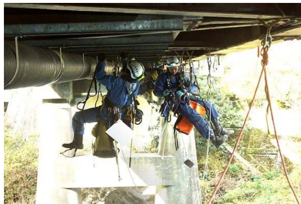
写真2 橋梁定期点検
