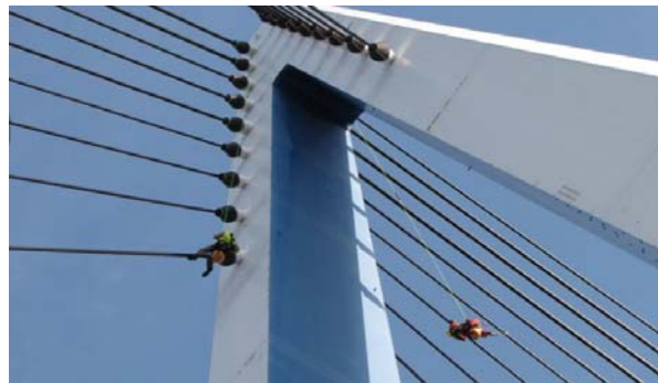
写真4 斜張橋のケーブル点検
