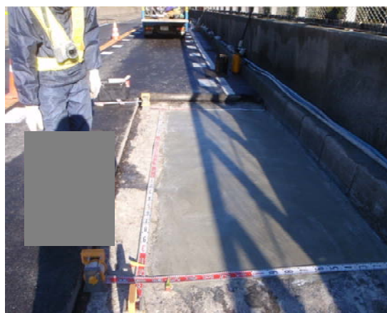
超速硬コンクリート打設完了
