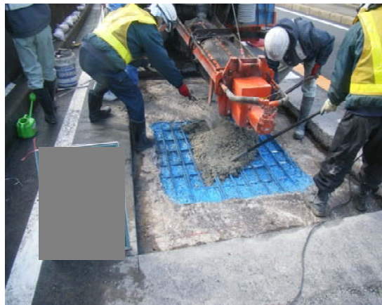
超速硬コンクリート打設状況
