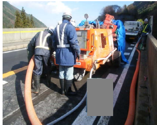
WJIによる床版はつり状況
