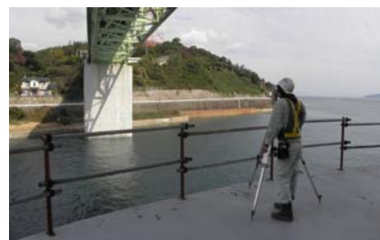
橋梁の計測風景
