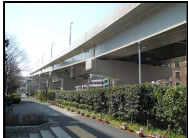
首都高速高架橋
