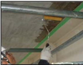
プライマー工
