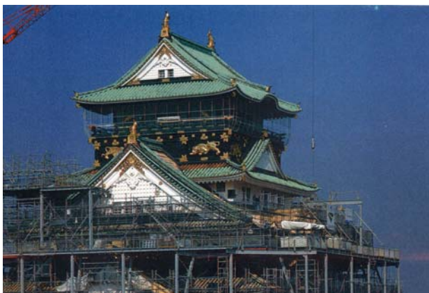
再アルカリ化工法施工例：大阪城「平成の大改修」 出展：甦った大阪城、関西広済堂
