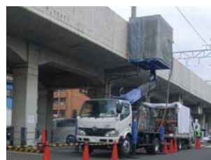
施工状況(高所作業車)
