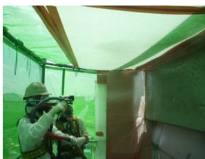
施工状況(橋梁)
