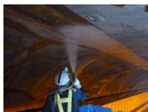
施工状況(トンネル)
