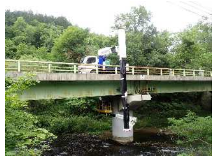
仮設備使用例
