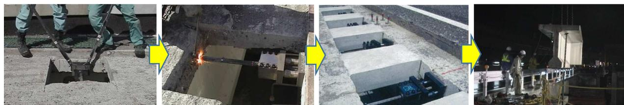
⑤イコライザの取付け、調整ボルトにトルク導入
