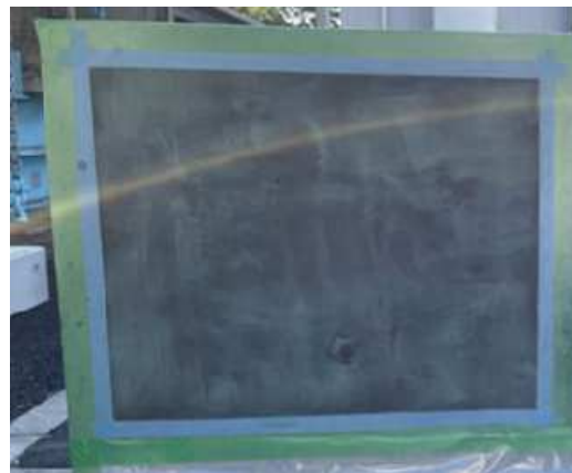
写真2 SBLN ジェルの塗布状況
