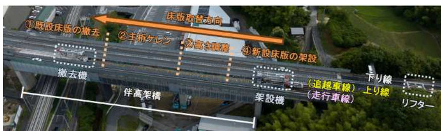
幅員方向分割床版取替工事施工中の伴高架橋
