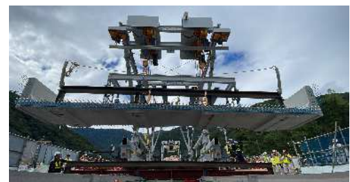
全断面床版取替工事の状況
