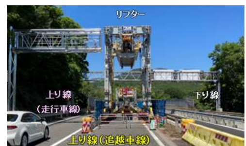
幅員方向分割床版取替工事の状況
