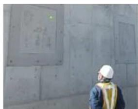
計測範囲を緑のレーザーで計測位置に表示する
