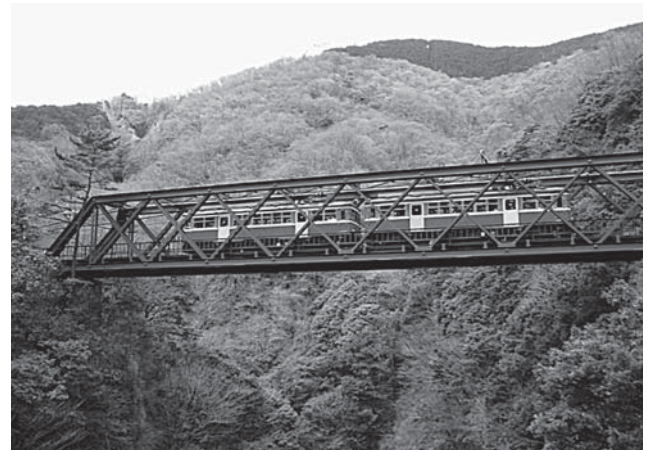
▲写真-2 早川橋梁
