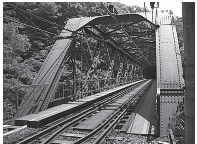
▲写真-3 早川橋梁
