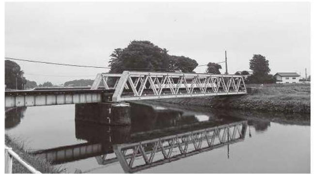
写真-1 下流側より望む五行川橋梁
