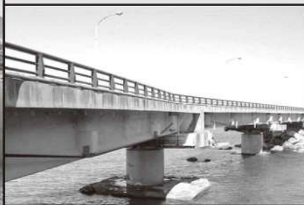
▲外ケーブル補強
