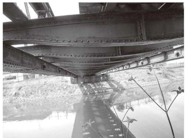
写真-3 横桁下フランジが魚腹形の横桁（同種他橋）
