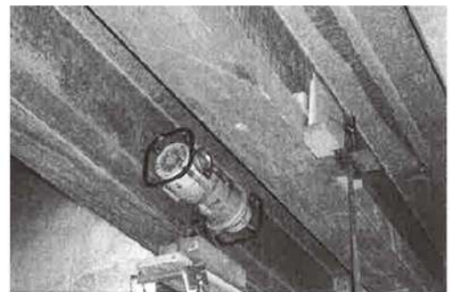
図-1 PC橋で測定中の可搬式X線装置
