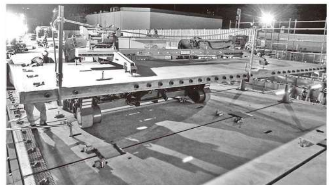
阪神高速3号神戸線でのUFC床版の架設
